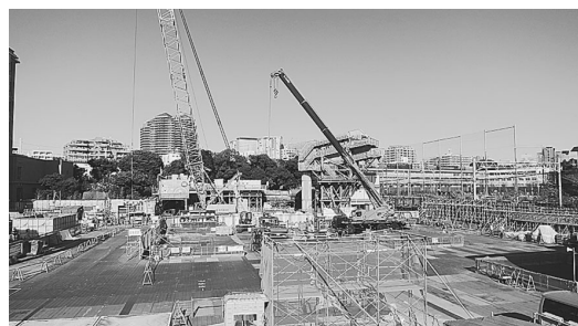
北品川非常口作業ヤード
