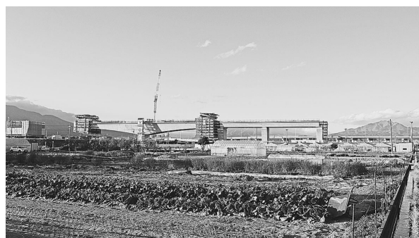
図表 I-3-(3)-2 山梨県内高架橋(中央市地内)
