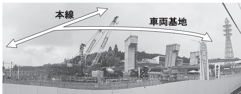
岐阜県駅工事現場の状況
