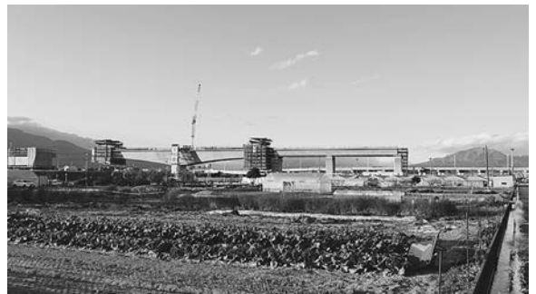
山梨県中央市のリニア工事状況（6年12月5日）
