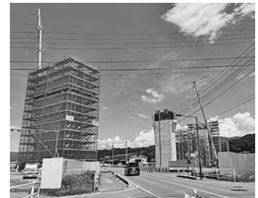
建設が進められる喬木高架橋
