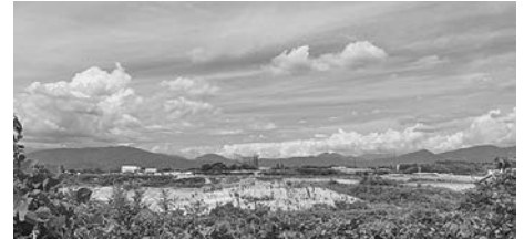
中部総合車両基地
