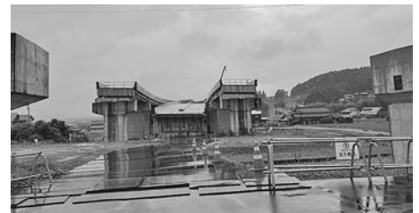
濃飛横断自動車道茄子川地内
