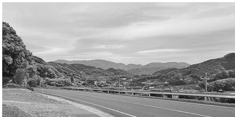
本坂トンネルを抜けて遠州三ヶ日方面を遠望
