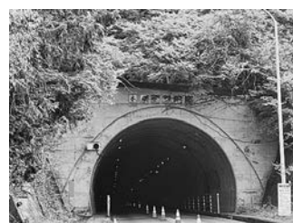
本坂トンネル入口（愛知県側）
