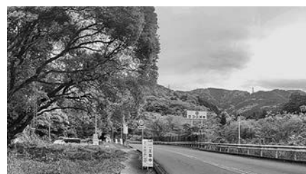
姫街道(国道362号)と本坂トンネル
