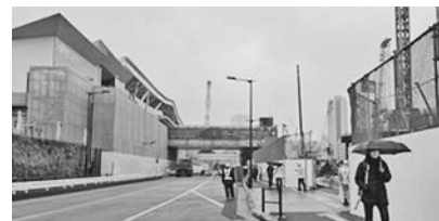
高輪ゲートウェイ駅（左）と再開発現場
