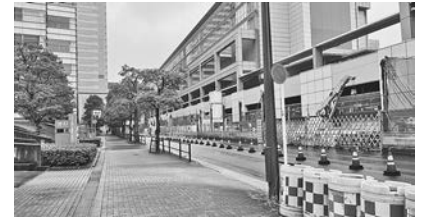
品川駅のリニア工事現場
