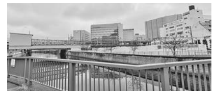
北品川非常口から目黒川を渡って伸びている発生土運搬コンベアと発生土仮置き場
