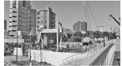
北品川非常口の工事ヤード 前の道路は山手通り、道路の上に発生土運搬のコンベアが見える
