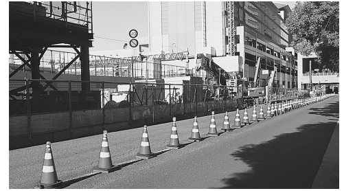
品川駅前の非開削工区 品川駅の3工区
