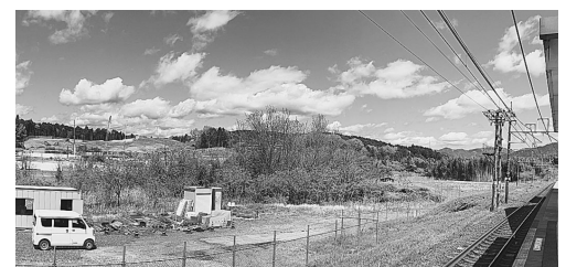
JR美乃坂本駅から見る岐阜県駅工事現場
