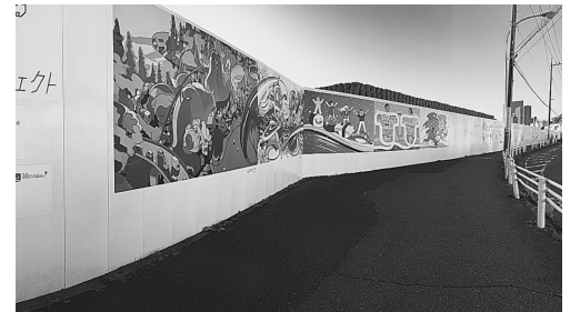
神奈川県駅の仮囲いと土嚢の山
