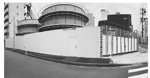
名古屋市中村区 仮囲いと工事プラント
