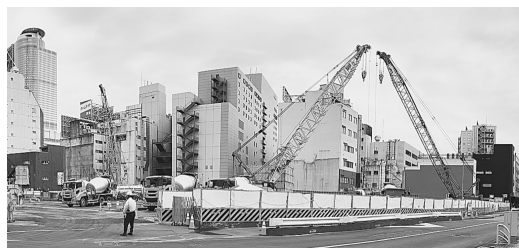
筈瀬川筋の工事状況（同②）
