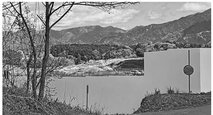
車両基地工事現場
