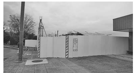
中央自動車道境川PA（上り）に隣接して 設置されている中央道高架橋橋脚設置工事ヤード
