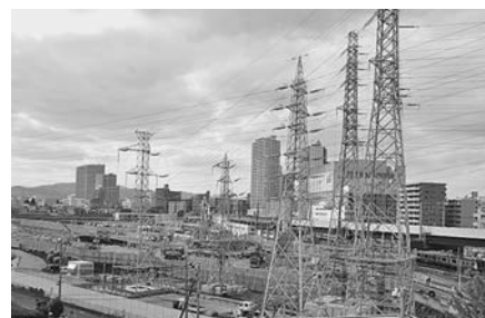
リニア関連工事（奥：JR・京王線橋本駅）
