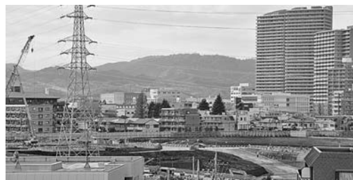
開削工事が始まっているリニア神奈川県駅予定地
