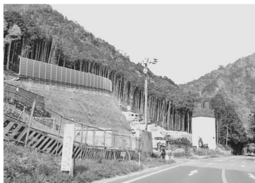
鳳来峡IC・東栄IC間も工事進む (新城市河合付近)
