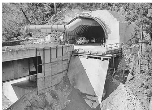
青崩トンネル坑口現場（浜松市天竜区水窪池島）
