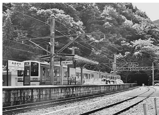
飯田線大嵐駅と大原トンネル
