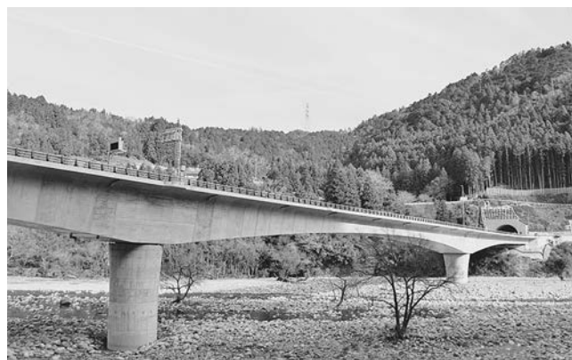
浦川インターチェンジ インター施設は写真右手に設置される （リニア対策課撮影）
