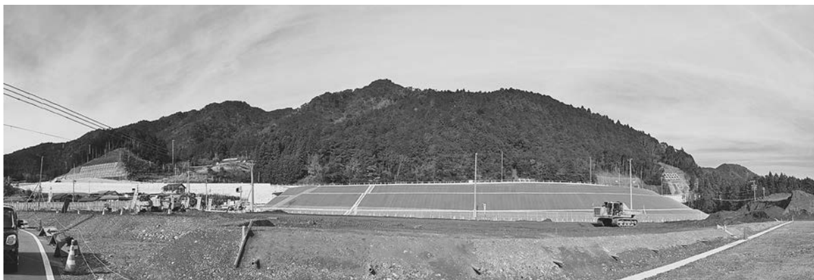
完成目指して追い込み段階の佐久間川合インターチェンジ （リニア対策課撮影）
