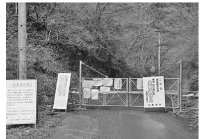
芝沢ゲート 崩落のため閉鎖
