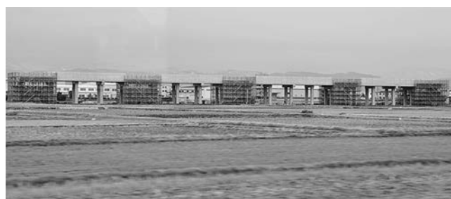
敦賀に向け延伸工事が進む北陸新幹線（小松市付近 29年11月） 飯伊地域でもやがてこのような光景が…（リニア対策課撮影）
