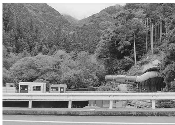
青崩トンネル本抗工事現場 （浜松市水窪池島地区）
